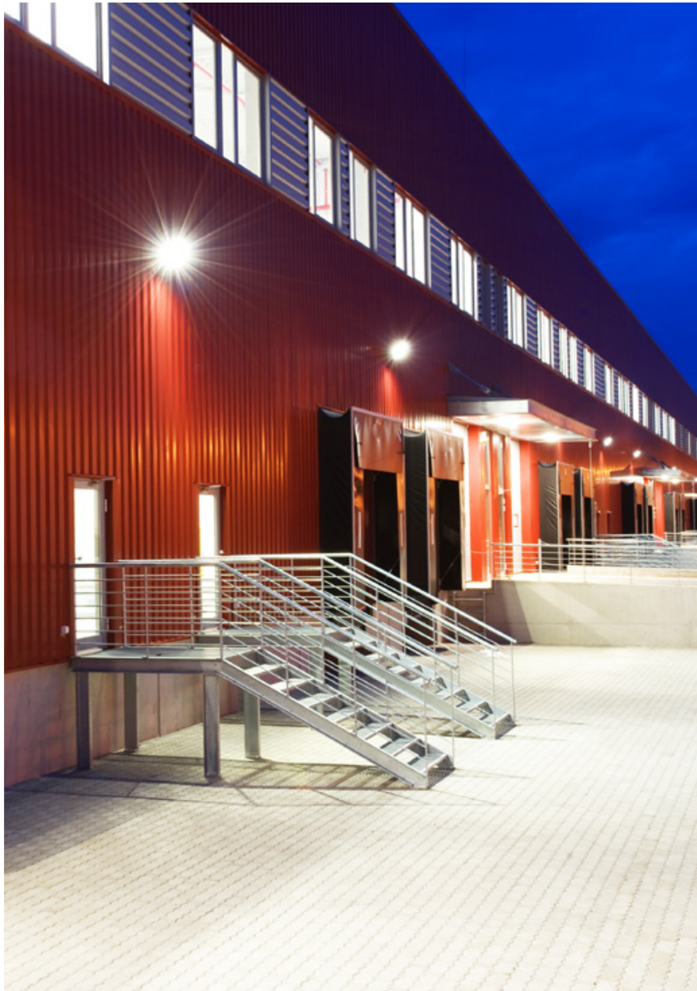
Verwendung von Quest 2 LED-Lampen für die Beleuchtung von Verladerrampen.
